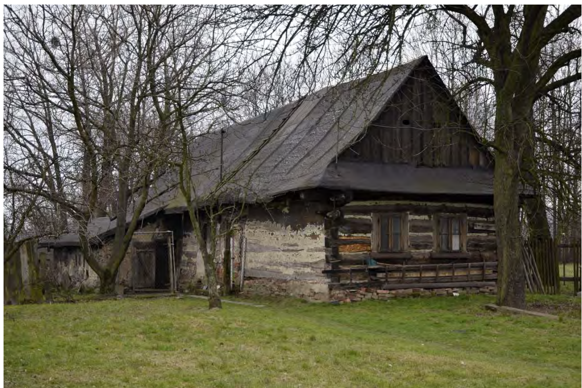
Pohled na roubený dům č. p. 416 v Ostravě- Bartovicích. Foto: O. Schejbal
